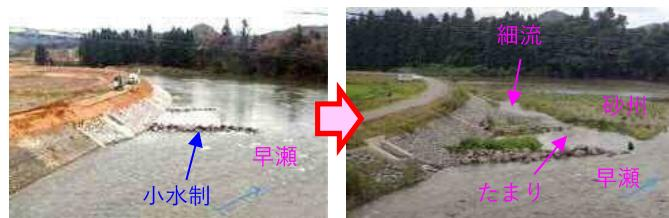
バーブ工（水制工）による瀬・淵等の再生のイメージ
