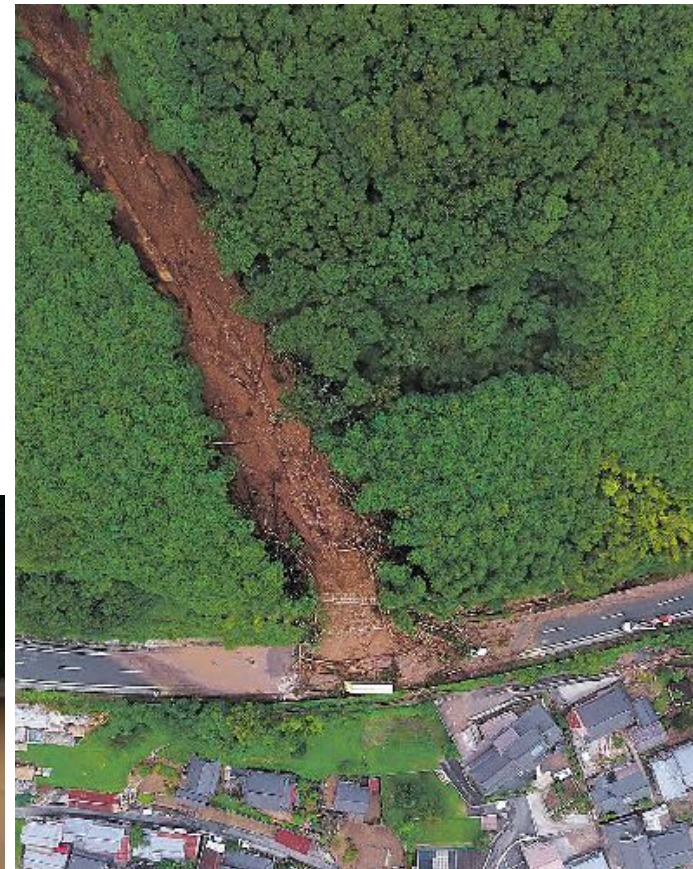
土砂災害が発生した中国自動車道下り線 = 4日早朝、新見市高尾（山陽新聞：NEXCO西日本）
