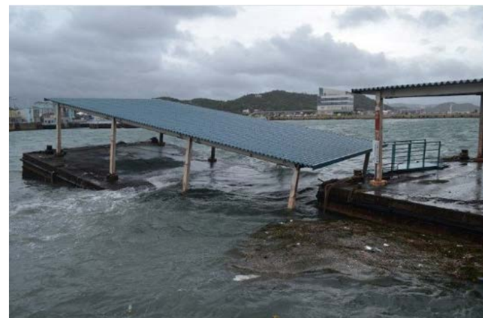
高波を受け、一部が水没した宇野港の浮棧橋 (写真：山陽新聞)
