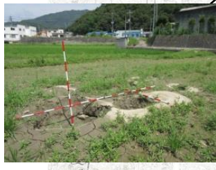
【基盤漏水】L=126m 吉井川右岸21k600付近
