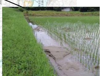
【基盤漏水】L=221m 吉井川右岸8k400付近
