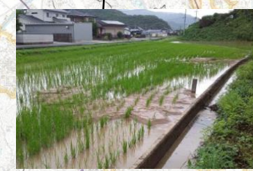
【基盤漏水】L=303m 吉井川右岸14k400付近
