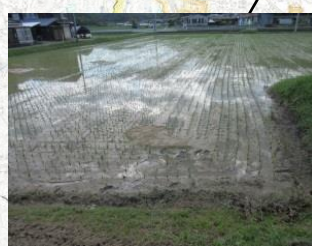
【基盤漏水】L=181m 吉井川右岸16k400付近
