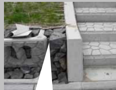
危ない! 石のぐらつき
