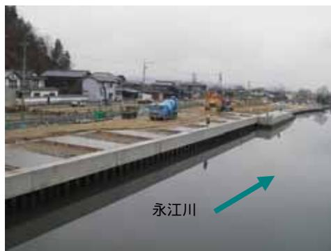
岡山市乙子 改修状況(築堤護岸整備)
