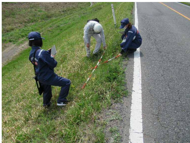
点検の様子(高梁川)
