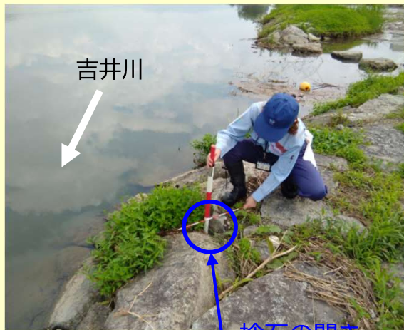
吉井川左岸10k付近 (吉井川河川公園親水広場)
