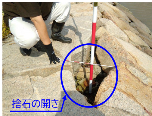
吉井川左岸4k000付近 (新地箇所河川敷公園)
