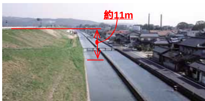
第一期改修で築造された高い堤防 (高梁川9.8K東岸側・倉敷市酒津)
