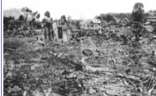
倉敷市真備町川辺字片原 家屋倒壊状況
