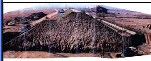
堤防断面の状況(小田川0.95K左岸)
