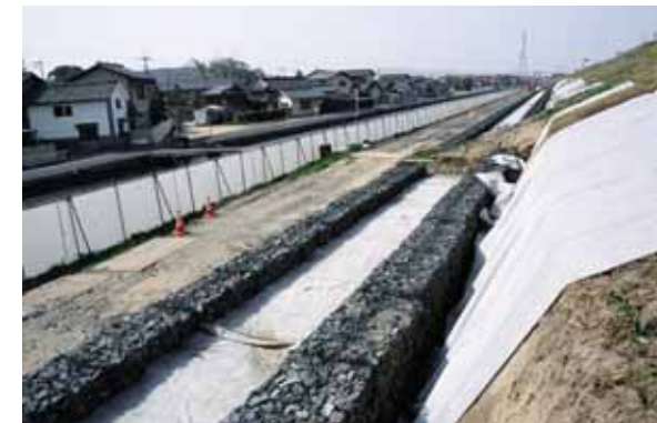
堤防補強におけるドレーン部の施工状況 (高梁川酒津地区)
