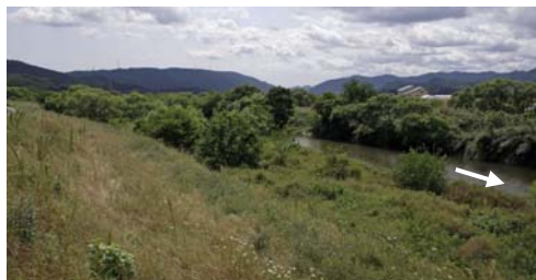
小田川 植生の繁茂状況
