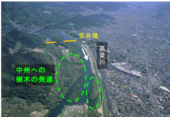
笠井堰付近の樹木の繁茂
