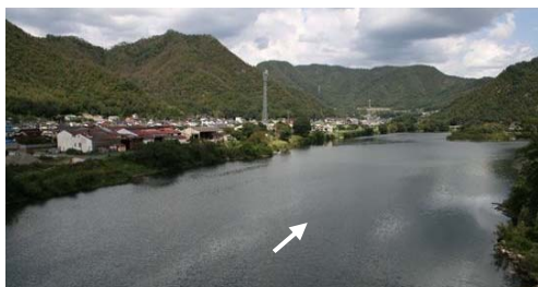
高梁川 国管理区間の上流端付近
