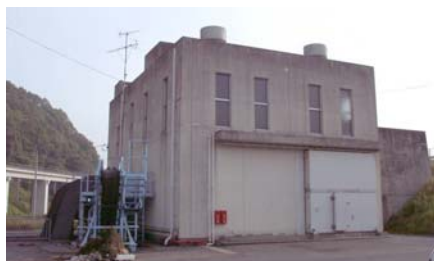
軽部排水機場(ポンプ場)
