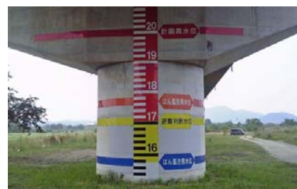
橋脚への量水標の設置状況 (高梁川)
