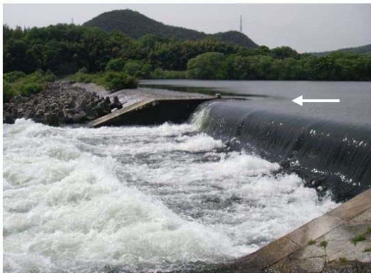
笠井堰 (固定堰)
