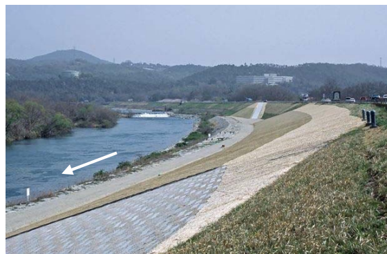
堤防補強の状況（高梁川酒津地区）
