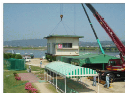
霞橋ゴルフ場上屋の撤去訓練
