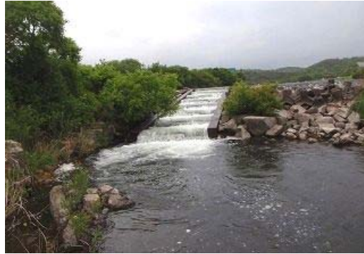
魚道現況（笠井堰）
