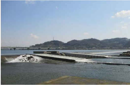
魚道現況（潮止堰：改良後）
