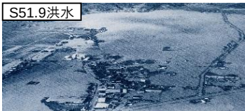
瀬戸内市長船町の浸水状況
