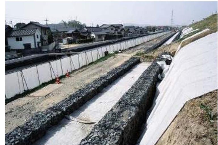
堤防補強におけるドレン部の施工状況
