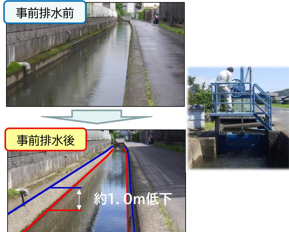
取水の中止・樋門の開放による水位調整
