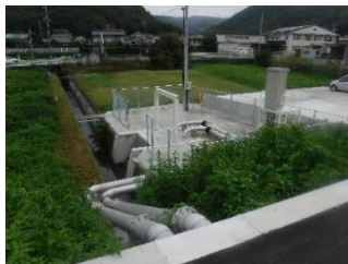
西町排水ポンプ場
