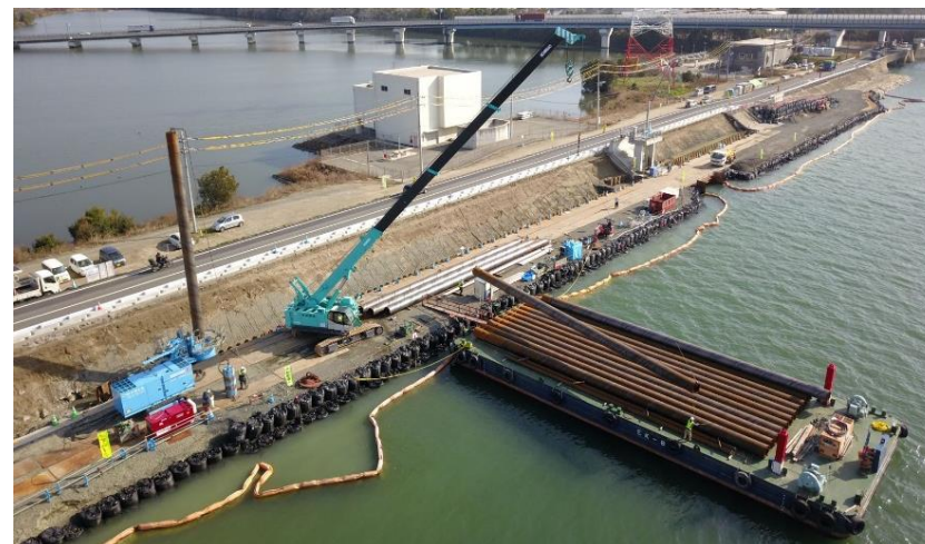
高潮・耐震対策の様子(鶴新田)
