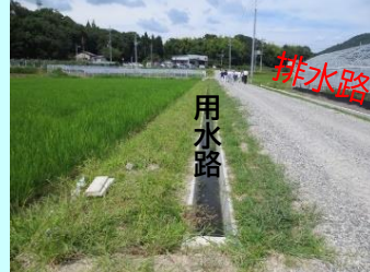
堰板等設置風景②
