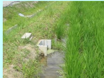
堰板等設置風景①
