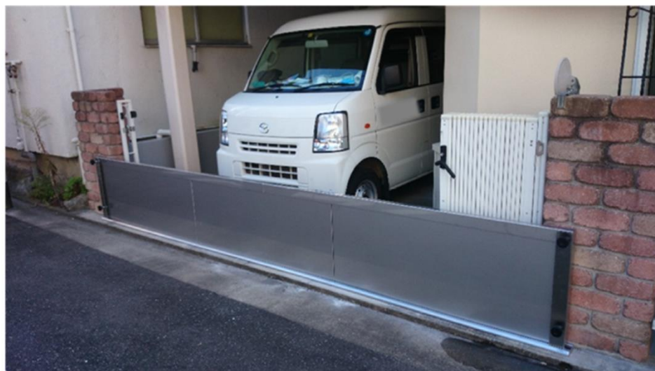
【止水板の設置例】
