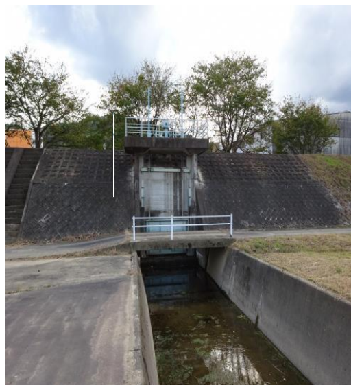
施工前（第2ポンプゲート）
