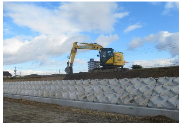
築堤の施工状況 (平井地区)
