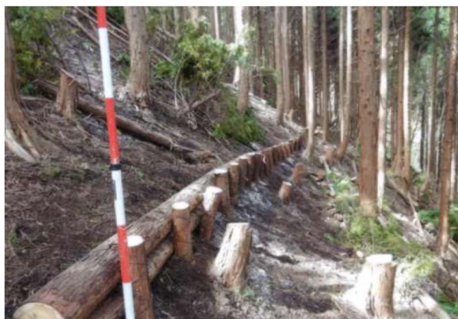
丸太筋工の完了状況
