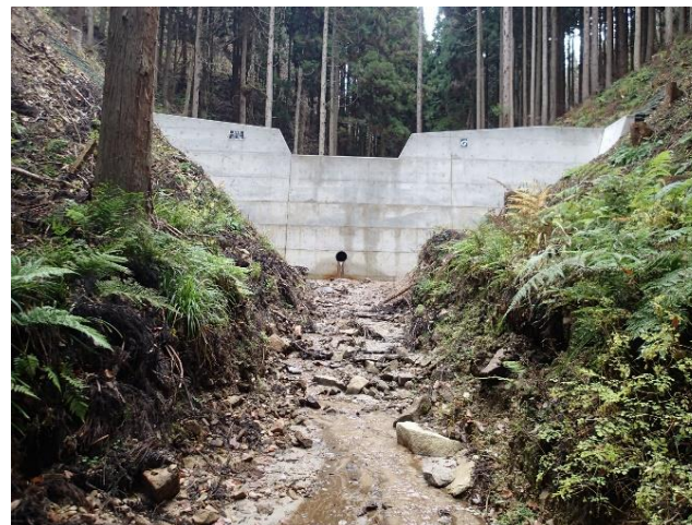
溪間工の施工状況
