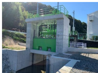
南部排水ポンプ場 (R4新設)
