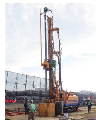
耐震対策の施工状況 (九幡地区)
