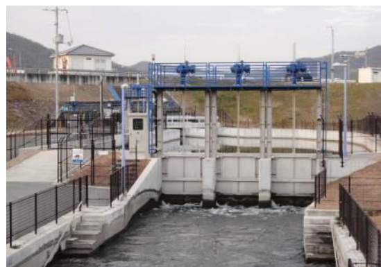
湛井堰ゲートの事前操作
