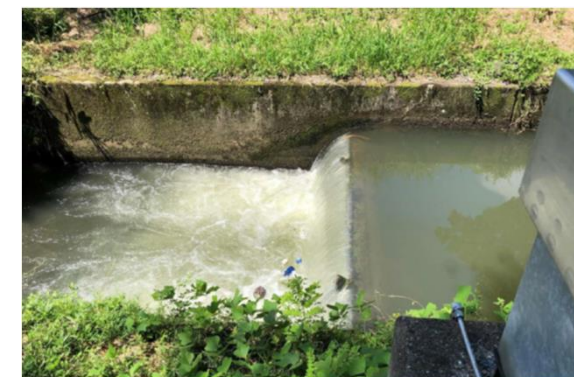
古地取水転倒堰の事前操作
