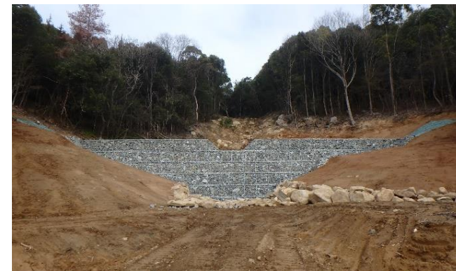
H31加賀山災害復旧工事(溪間工1基)
