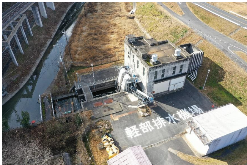
軽部排水機場の運転水位の見直し
