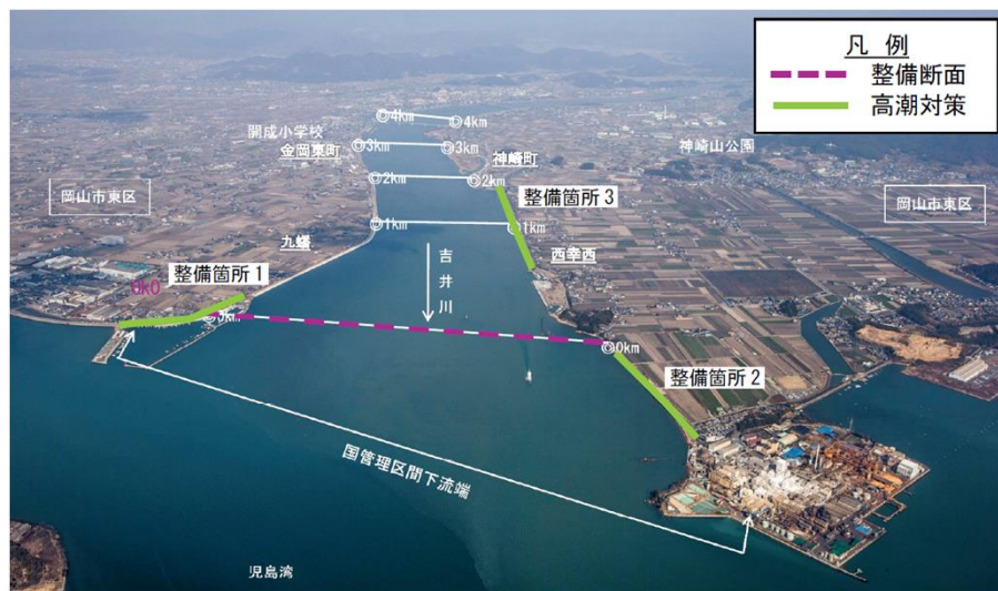
高潮対策区間(九幡・西幸西地区)
