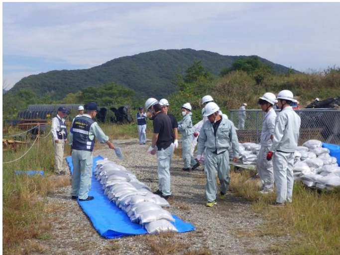
改良積み土のう工法
