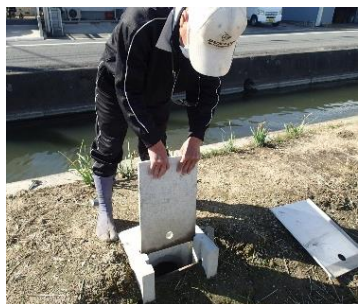
堰板等設置状況(ほ場)
