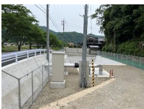
梶江排水ポンプ場
