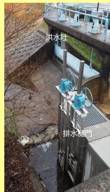
岩田大池の洪水吐と排水樋門(上流側から)
