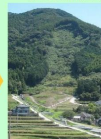
山腹工施工後9年後の様子 (平成30年9月撮影)
