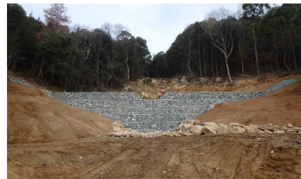
H31加賀山災害復旧工事(溪間工1基)
