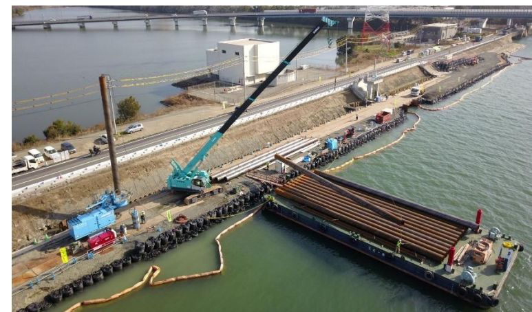
高潮・耐震対策の様子(鶴新田)
