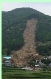
被災直後の様子 (平成21年7月撮影)
