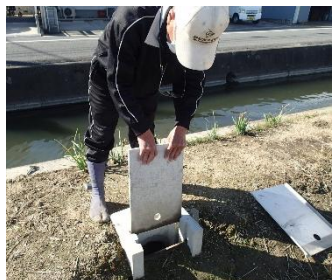
堰板等設置状況(ほ場)
