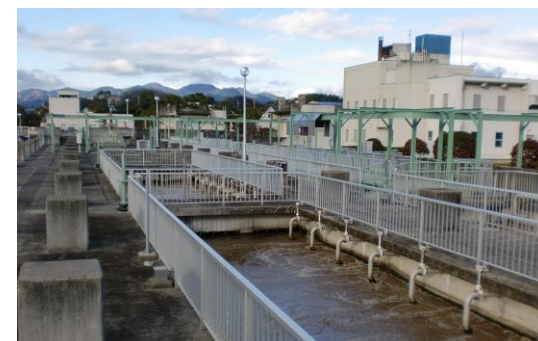
津山浄化センター
