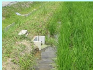
堰板等設置風景①
