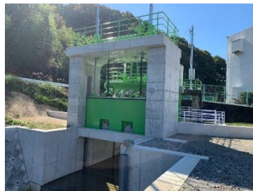
南部下水道 排水ポンプ場 (R4)
