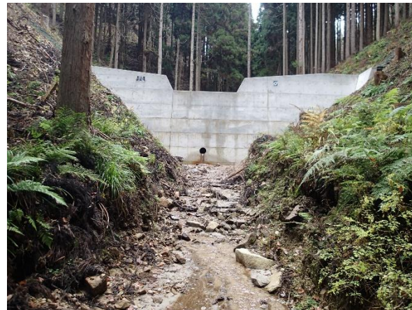
溪間工の施工状況
