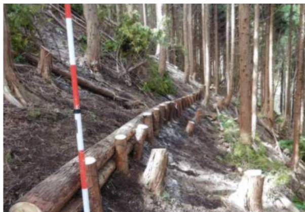
丸太筋工の完了状況
