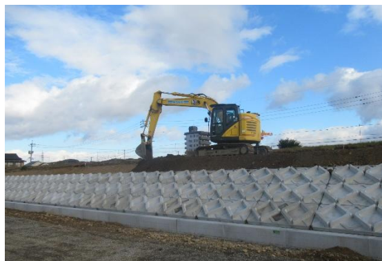
築堤の施工状況 (平井地区)
