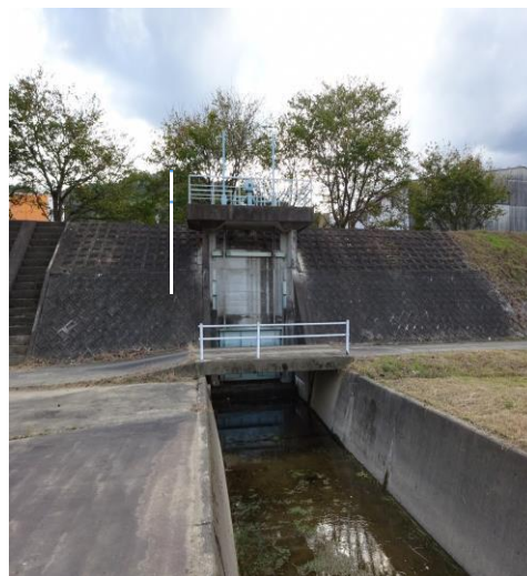
施工前(第2ポンプゲート)
