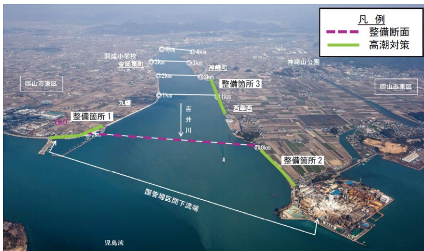
高潮対策区間(九幡・西幸西地区)
