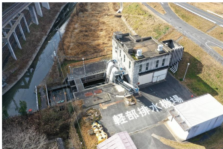
軽部排水機場の運転水位の見直し
