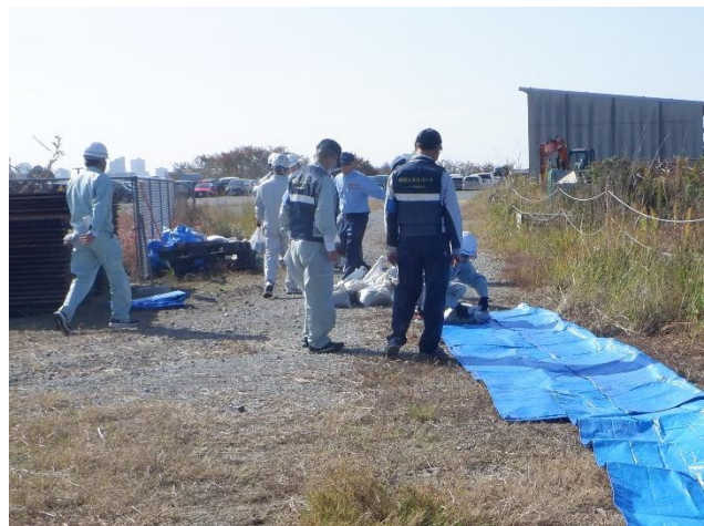
改良積み土のう工法
