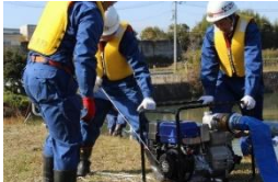
可搬式排水ポンプを活用した訓練
