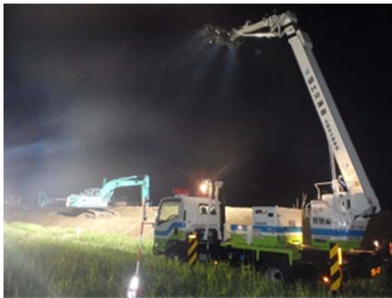
堤防復旧工事の夜間照明
