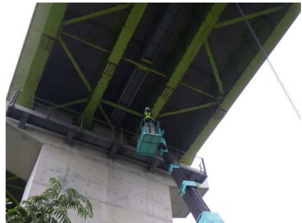
橋梁緊急点検
