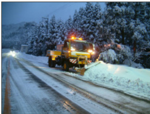
除雪トラックによる作業状況
