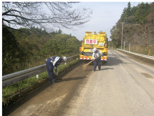
路面清掃（散水） ちばけんきみつし 【場所：千葉県君津市】
