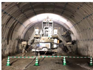
《トンネル掘削》
