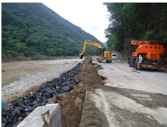
大型土嚢の製作・設置
