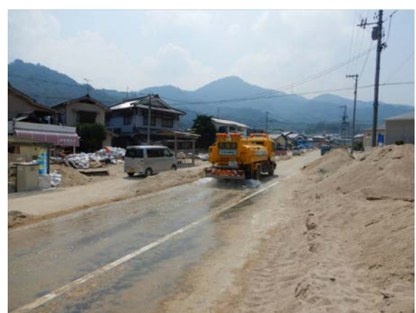
路面清掃（散水）
