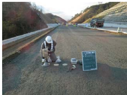
▲ 砂置換法で品質管理をしている様子▲
