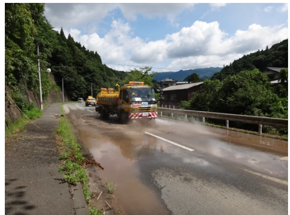
路面清掃（散水）
