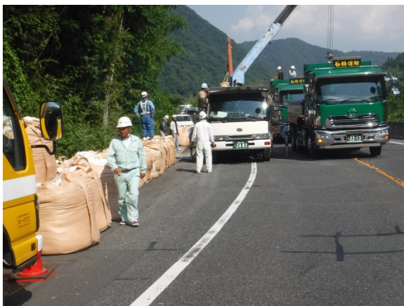
大型土嚢の製作・運搬・設置
