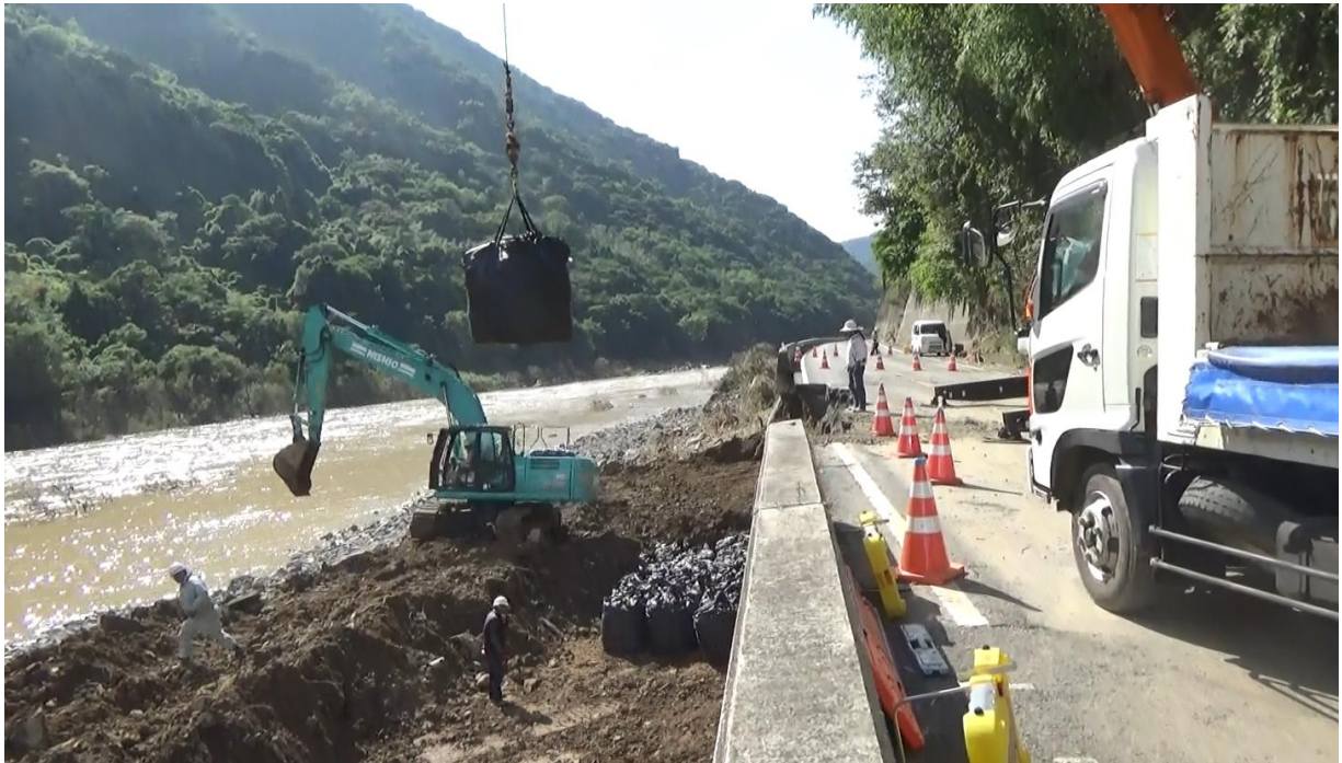
△総社市種井付近の護岸崩壊箇所の土のう積みを実施
