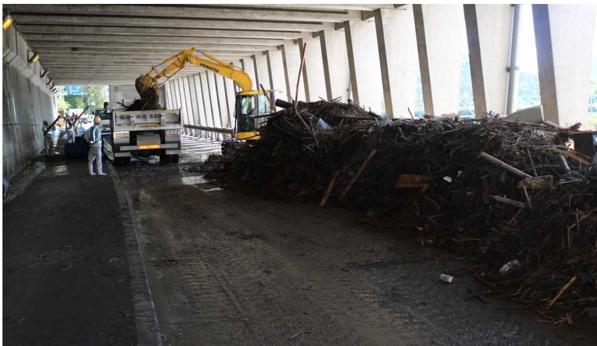
△総社市美袋洞門における瓦礫撤去作業
