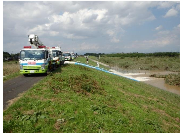
排水ポンプ車による排水作業②
