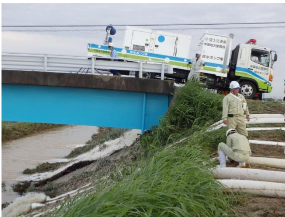
排水ポンプ車による排水作業①
