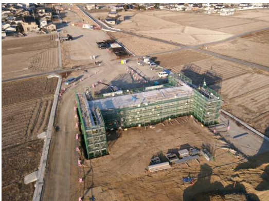
《工事現場の様子》平成30年1月 現場打ち函渠工
