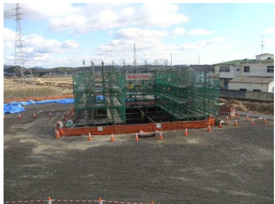
《工事現場の様子》平成30年1月 橋梁下部工
