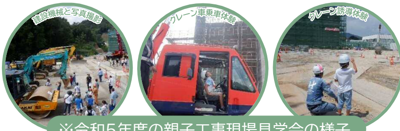
※令和5年度の親子工事現場見学会の様子
