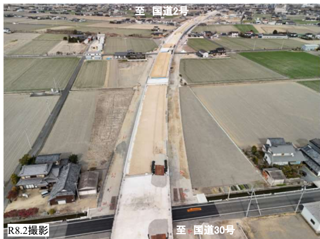
【写真①】 藤田地区 施工状況
