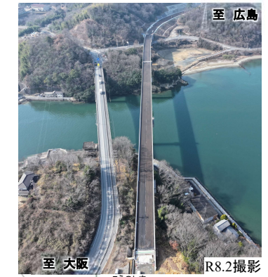
【写真②】神島地区の施工状況
