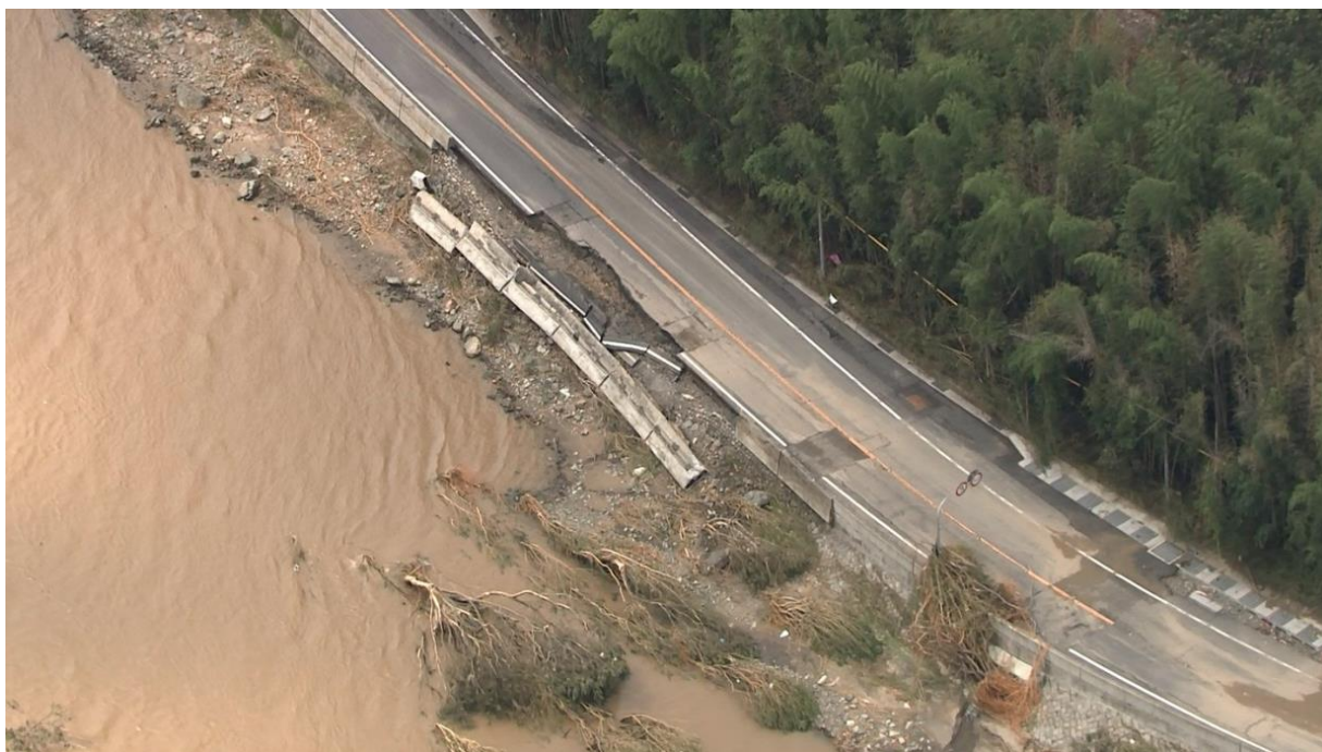
△総社市種井における護岸崩壊状況（ヘリ画像）
