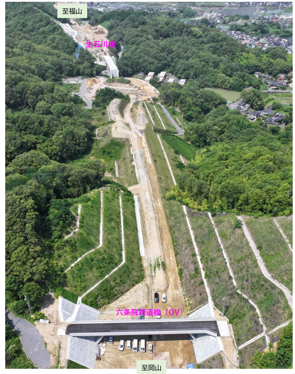
六条院中地区 施工状況
