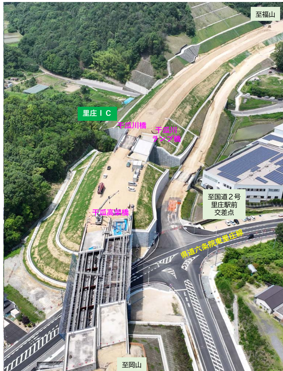
里庄 I C 施工状況
