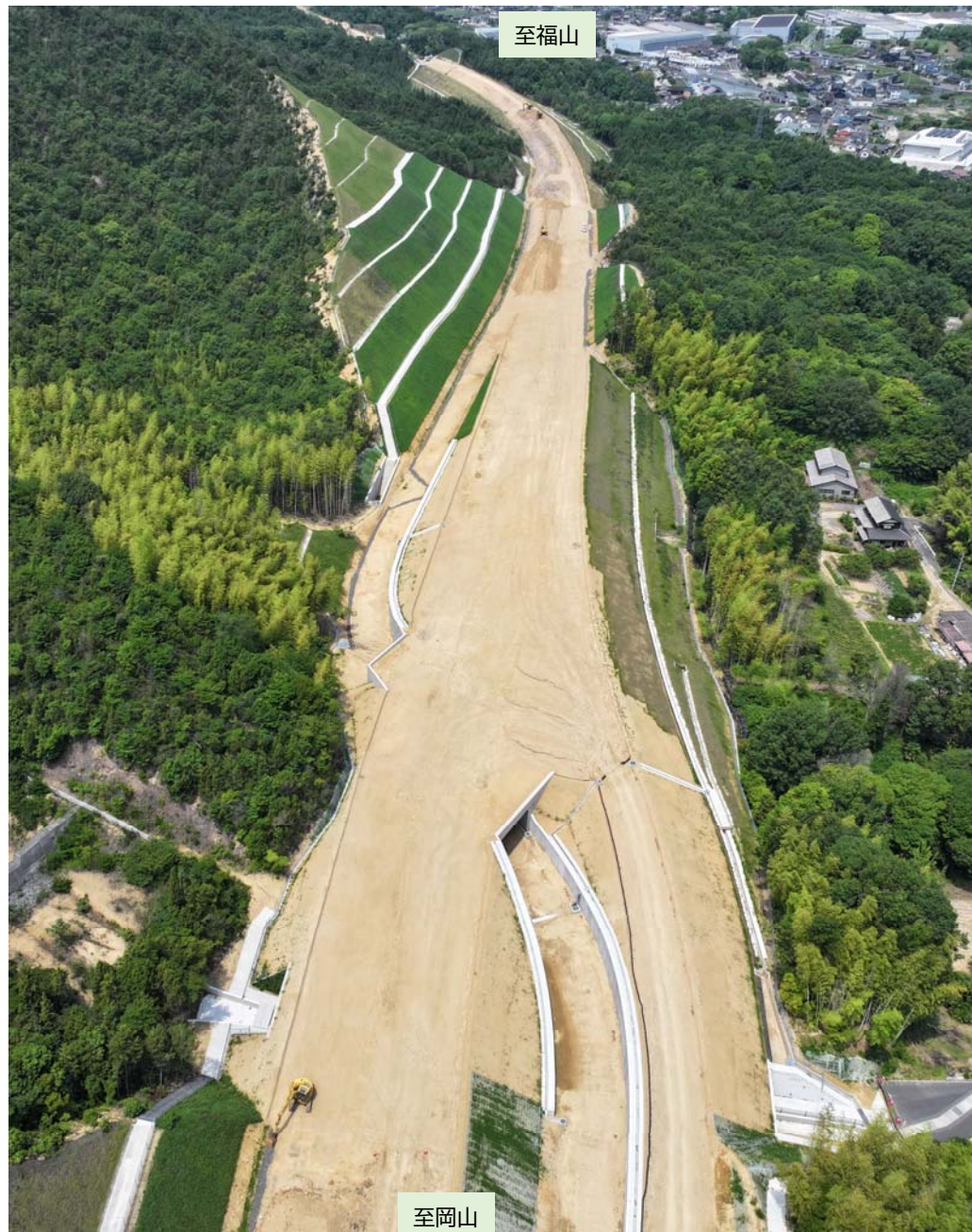
里庄町新庄（浜中東工区） 施工状況
