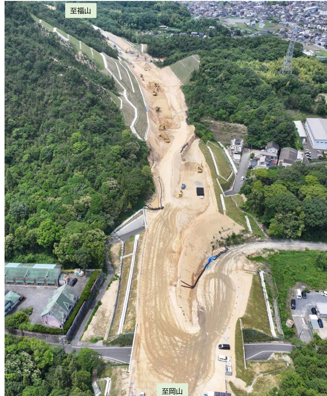
里庄町浜中（浜中中工区） 施工状況
