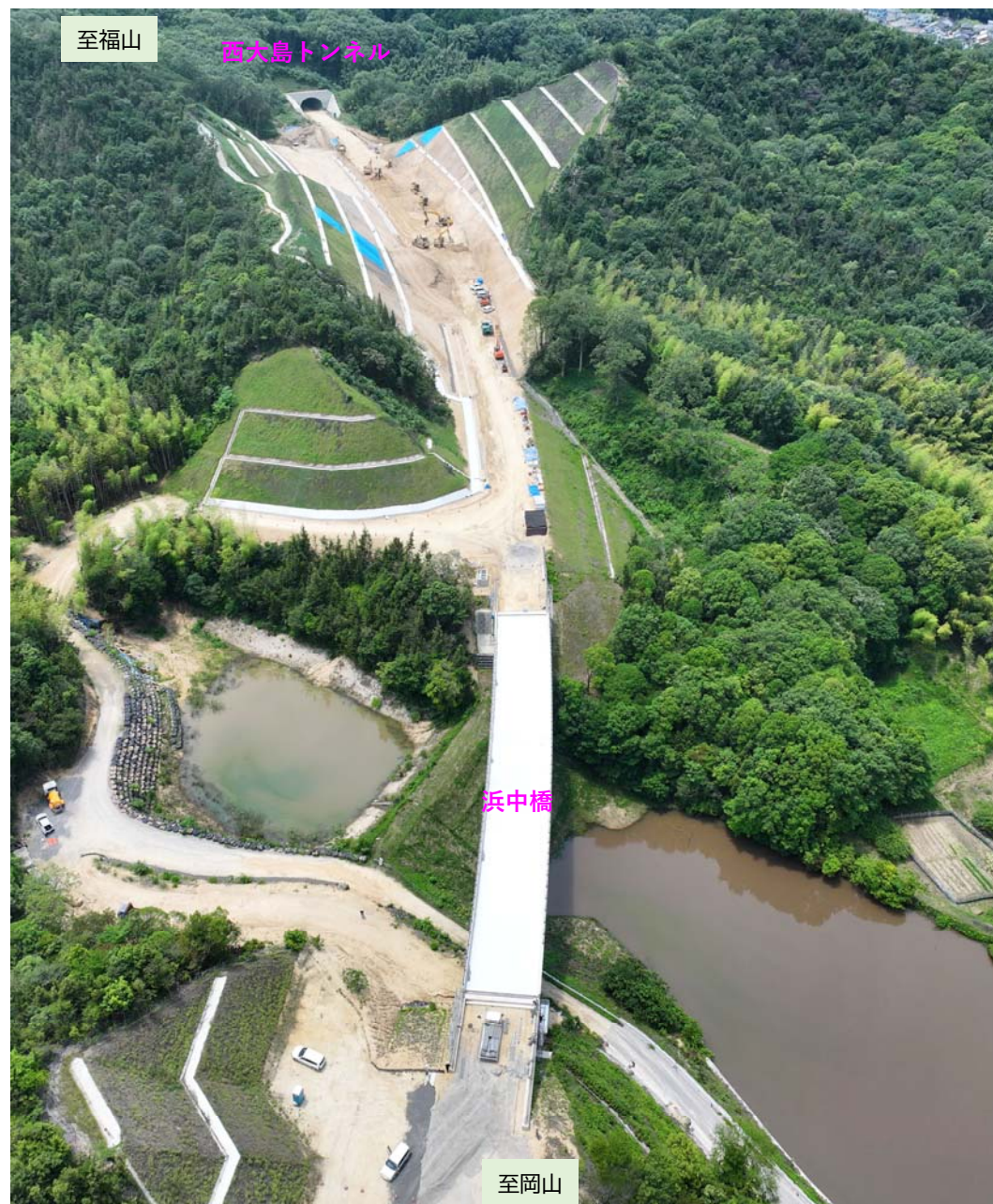
笠岡市西大島地区（１）（浜中西工区） 施工状況
