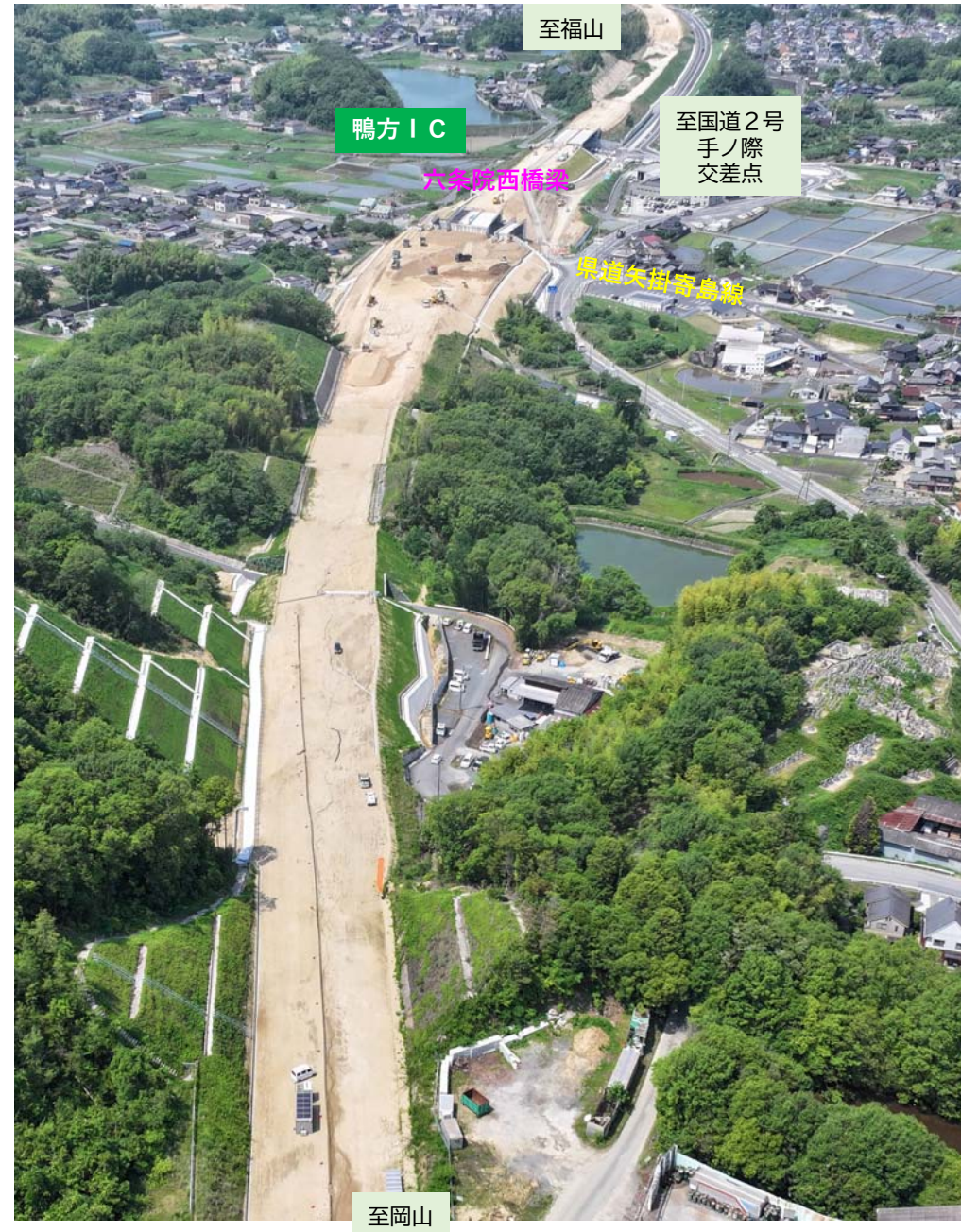
六条院西地区 施工状況
