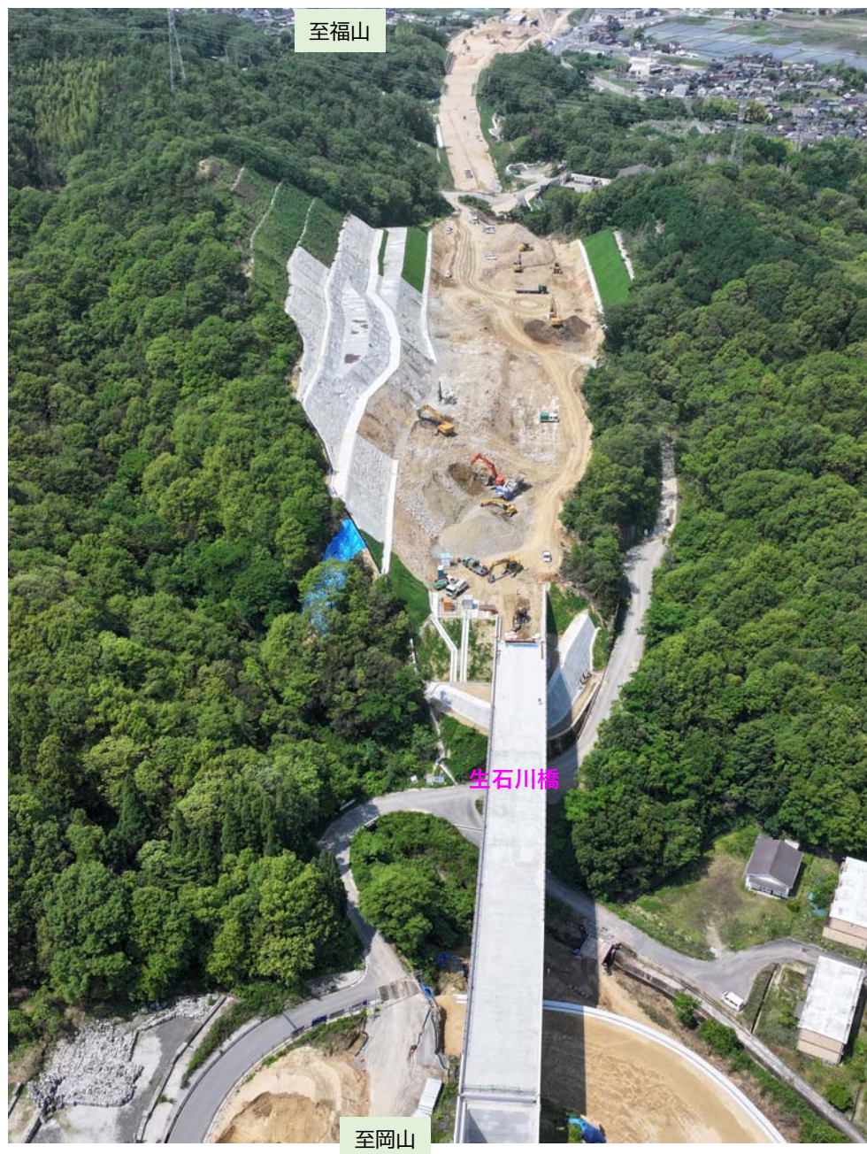
生石川橋付近 施工状況
