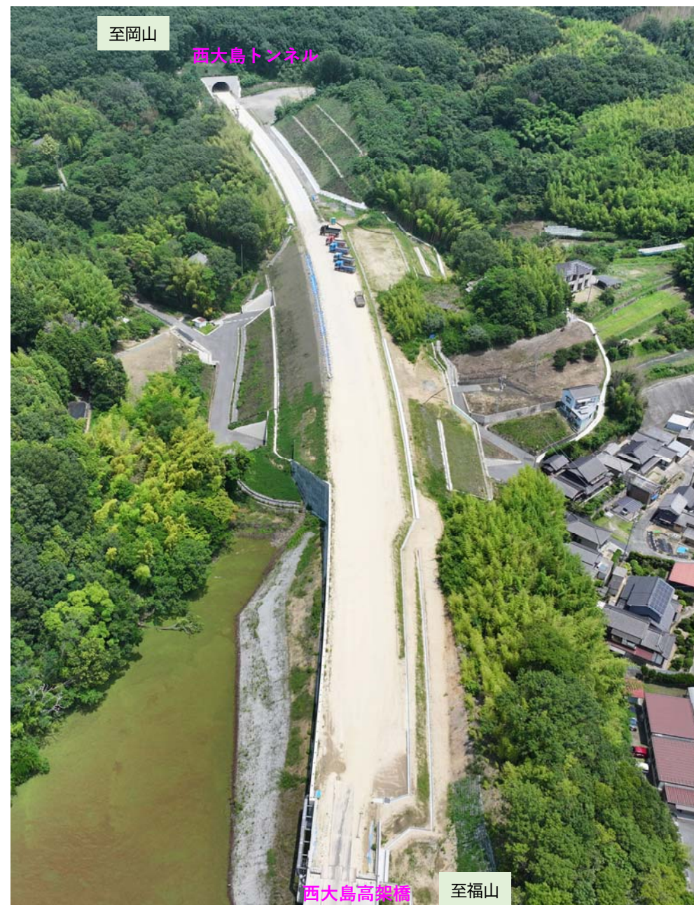
笠岡市西大島地区（２） 施工状況
