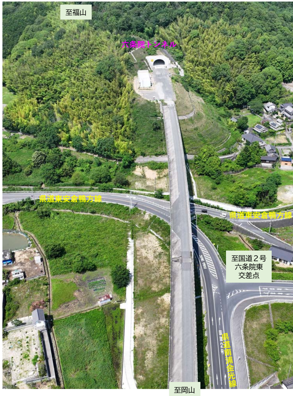
<284>県道東安倉鴨方線付近 施工状況
