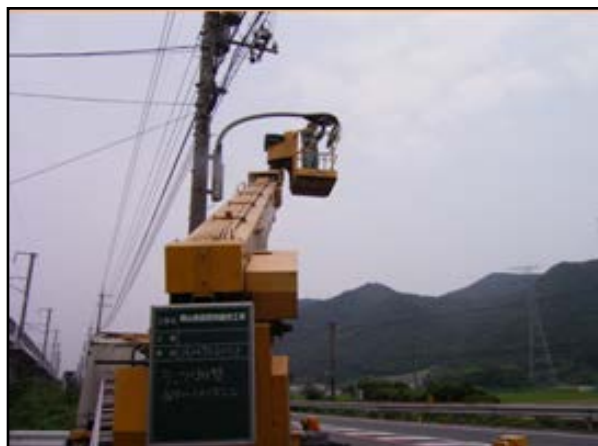
道路照明灯のランプ球替え
