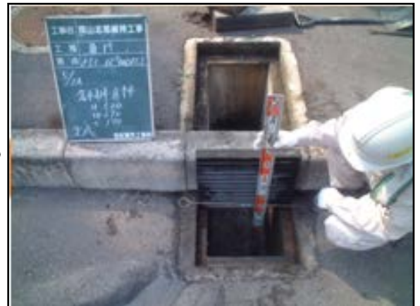
排水施設（構造物）清掃【清掃後】
