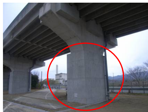
橋脚補強（RC巻立）【対策後】
