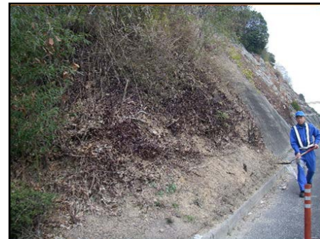
定期巡回(法面)
