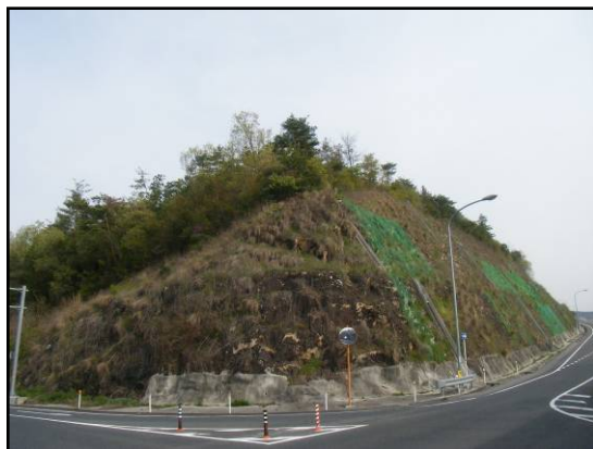
法枠による法面保護【対策前】
