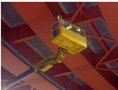
橋梁点検車による点検
