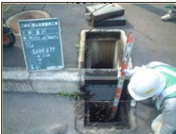
排水施設（構造物）清掃【清掃前】
