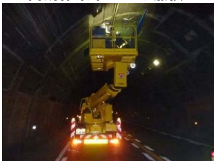
高所作業車による点検
