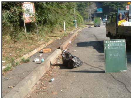
通常巡回(落下物処理)
