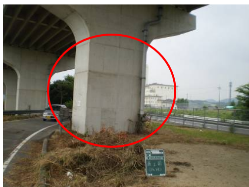
橋脚補強（RC巻立）【対策前】
