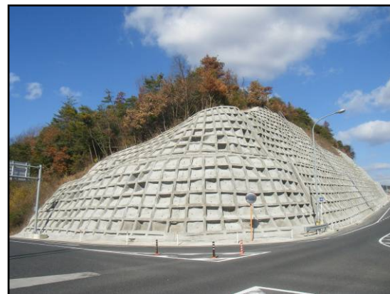
法枠による法面保護【対策後】
