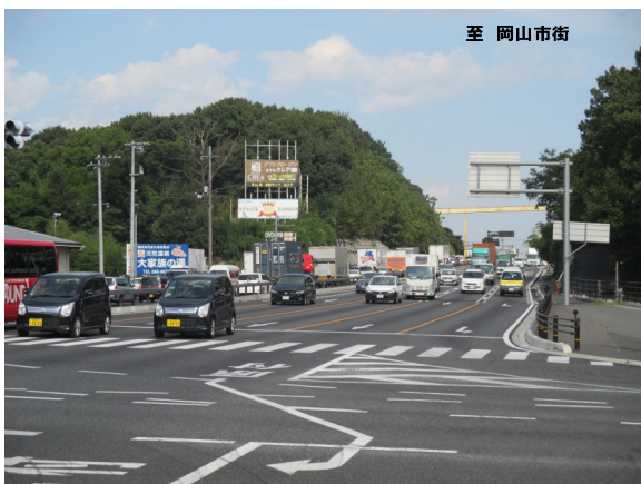
< 国道2号 妹尾西交差点(岡山市南区) 対策事例 >
