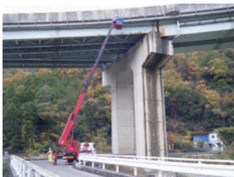
リフト車による橋梁点検
