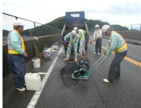
穴ぼこ（ポットホール）補修
