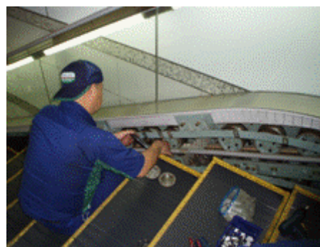
昇降機設備点検（エスカレーター）
