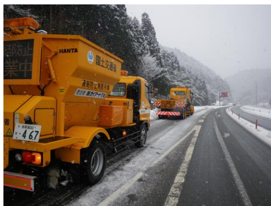
凍結防止剤散布状況
