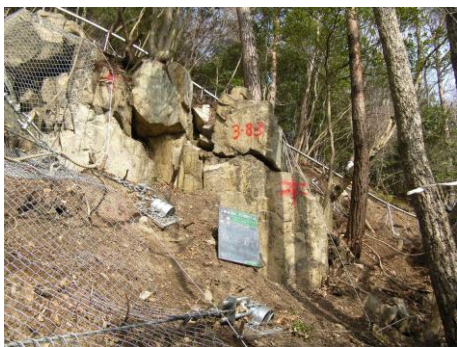
ロープネット工対策前
