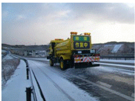
凍結防止剤散布作業
