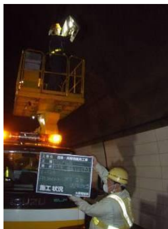
トンネル照明球替
