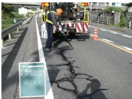
補修材（シール材）注入
