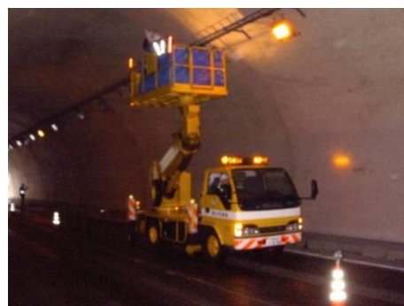
高所作業車による点検
