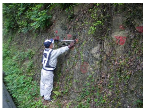
【定期巡回（法面）】
