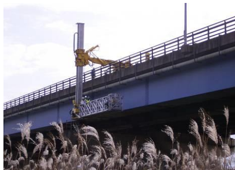
橋梁点検車による点検
