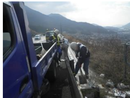
【側溝清掃】 清掃中
