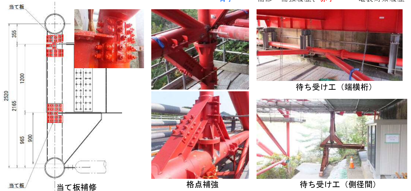
図-1.7 亀裂対策工施工状況
