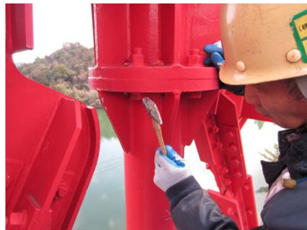
吊り材上側のたたき点検状況
