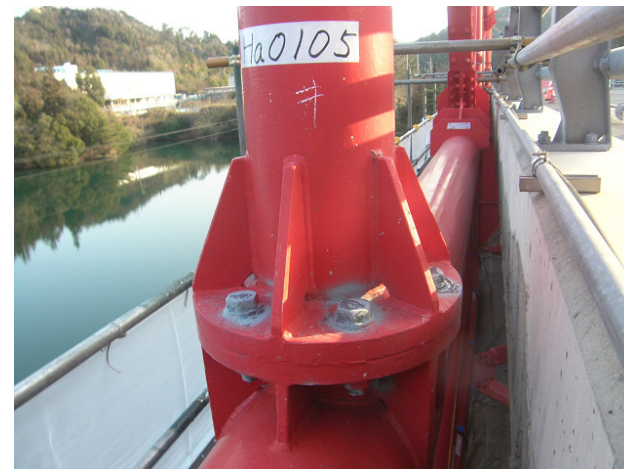
吊り材下側のたたき点検後処理
