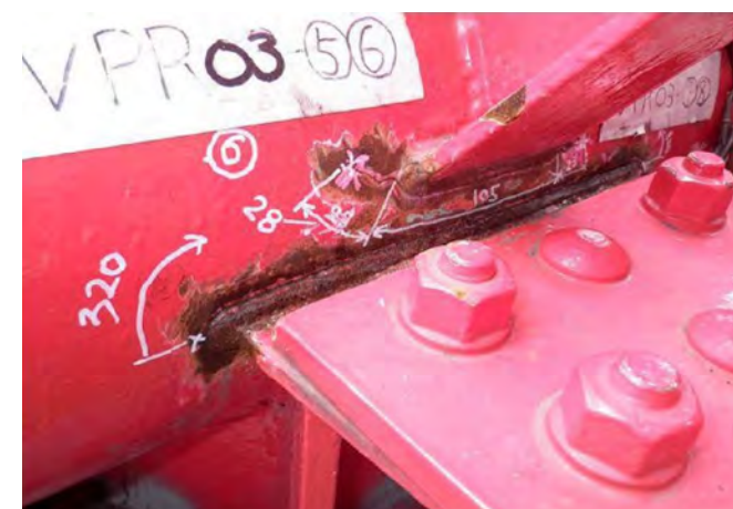
写真-2.5 下弦材とガセットの接合部 (VPR03_⑦⑧)
