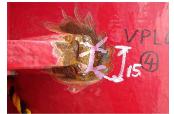
写真-2.3 垂直材と横桁下フランジ (VPL2④)
