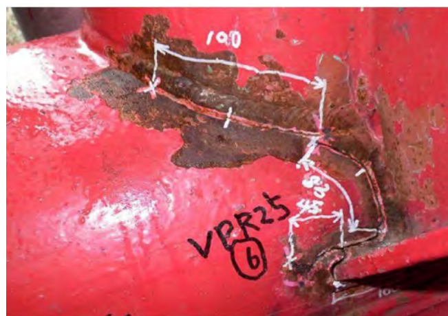
写真-2.4 下弦材とニーブレースフランジ (VPL25⑥)
