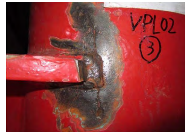
写真-2.2 垂直材と横桁上フランジ (VPL2③)
