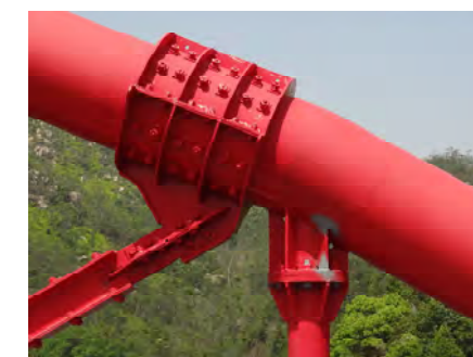
写真-3.1 高力ワンサイドボルト施工事例 (伊達橋耐震)
