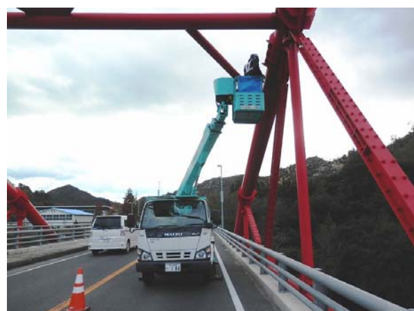
高所作業車による点検状況
