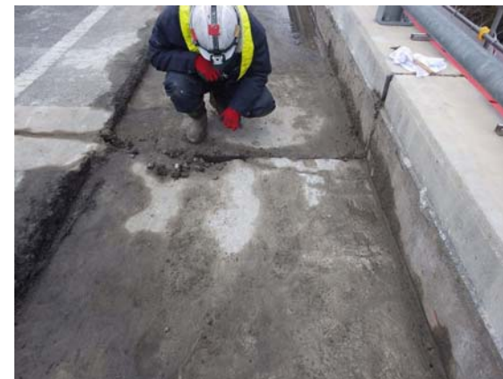
下り線歩道部調査状況
