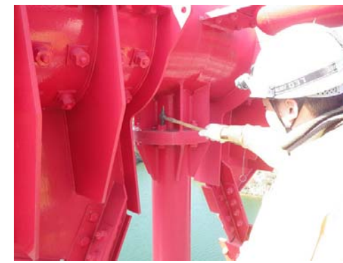
F11T たたき点検状況
