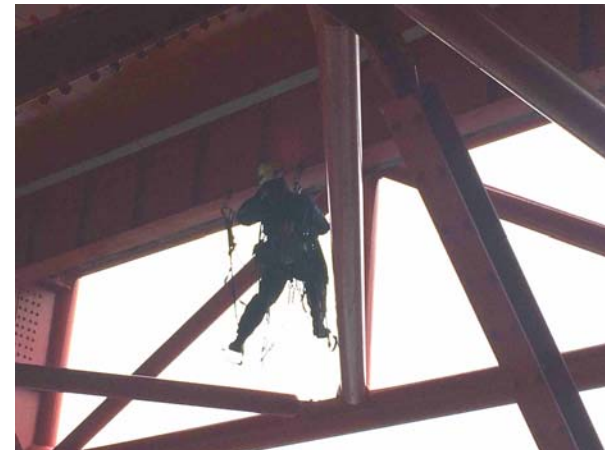
特殊高所技術による点検状況
