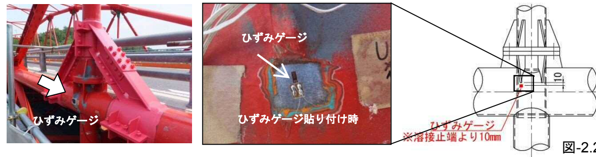
■VPR19 吊材と上弦材接合部（格点補強部）計測位置
