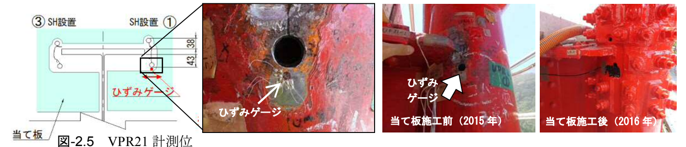
■当て板補修（VPR21）計測位置
