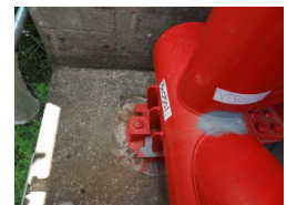
支承による拘束(起点上り線側)
