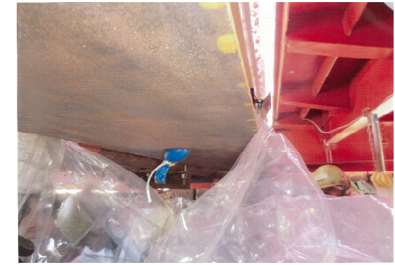
写真-3.2 バルーンによる削孔部の閉塞
