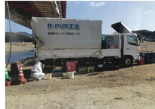
写真-3.1 現場製作状況
