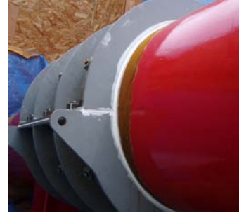
耐震補強部材とアーチリブの接合部のシール材（耐震補強工事写真より抜粋）
