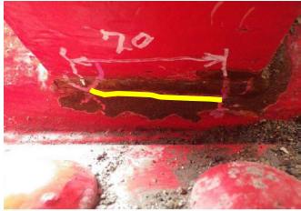
写真-1.1.3 ニーブレース
