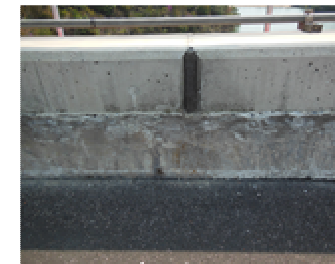
写真-1.3.1 歩道側地覆
