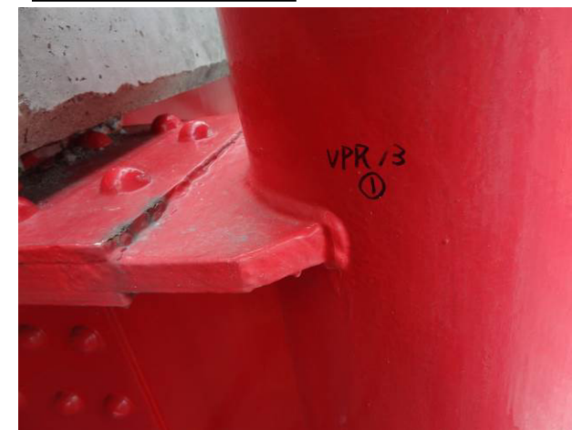
写真：横桁上フランジ
