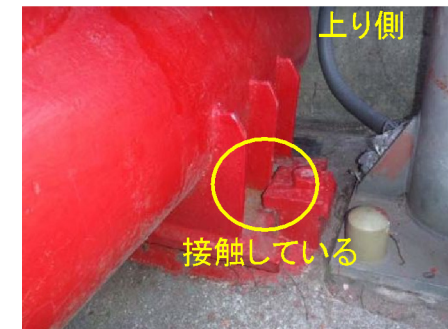
写真-5.3 支承の接触状況
