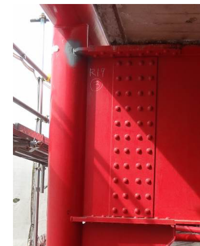
写真：垂直材と横桁の接合部
