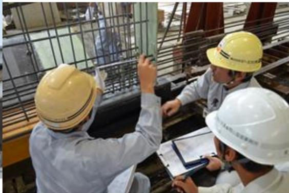
中に入っている鉄筋が正しく作られているか、ミリ単位で細かくチェックします。
