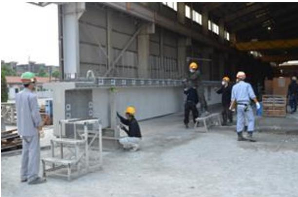
コンクリートを打った橋桁（はしげた）です。最後の仕上げは手作業でいねいに。
