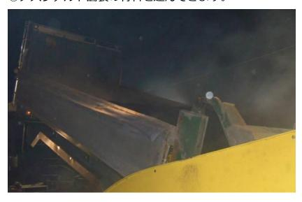
アスファルト舗装の材料のことを、アスファルト合材(ごうざい)といいます。 アスファルト合材の温度は 110 度以上。トラックの荷台を保温シートで覆って、 温度が下がらないように気を配ります。
