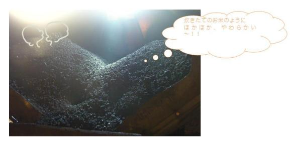
○湯気が立っているアスファルト合材を敷きつめて、『アスファルトフィニッシャ』という機械で平らになるようにならしていきます!
