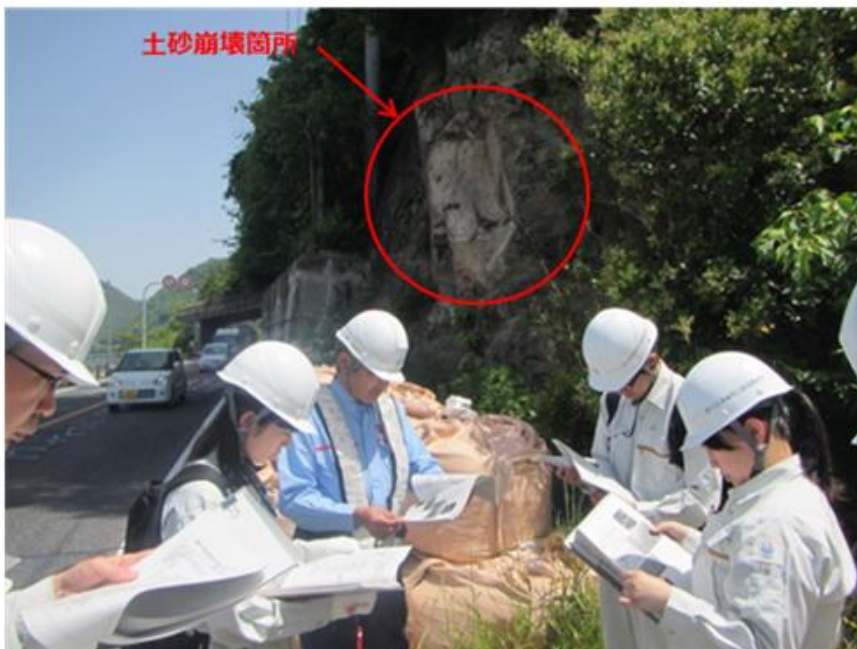
H29.10.21発生の土砂崩壊現場にて (R180総社市井尻野)
