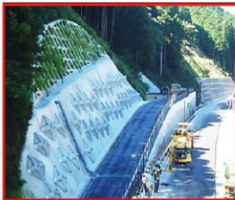
きりど 切土工事が完成！ 8月8日取材時
