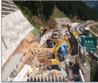
ようへき 擁壁を施工中 5月11日撮影
