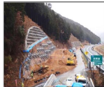
じみあつばん 受圧板まもなく設置完了 3月20日 撮影
