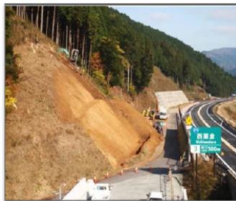
こうしょうのりめんくっさくき きりど 高所法面掘削機による切土状況 (Vol.2) 11月5日 撮影
