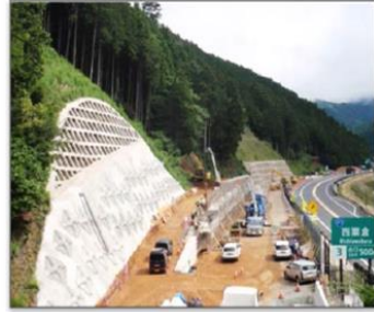
のりめん 法面工事完成！ 6月13日撮影
