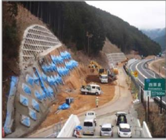
のりめん ※ 法面モルタル吹き付け 4月5日撮影
