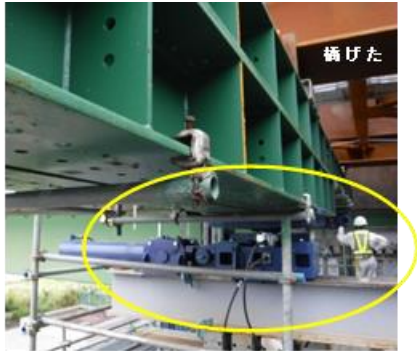
(写真) この現場で使用している送りジャッキ (1回の送り出で、1m送り出せます。)
