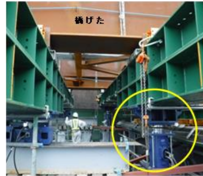
(写真) この現場で使用している盛替えジャッキ
