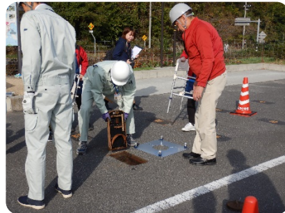
鉄蓋を取り外します
