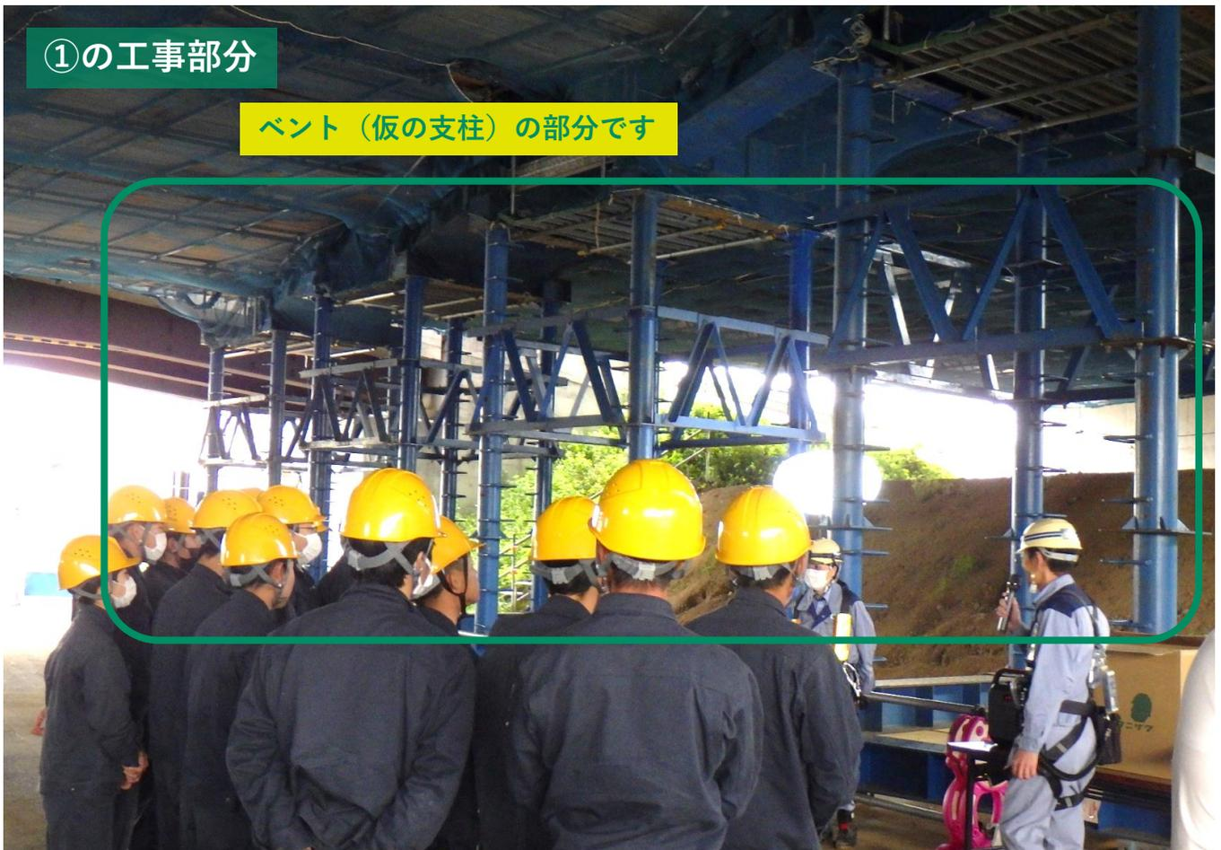
こちらの部分は既に橋桁が設置され、RC床版工事をを行っています。
