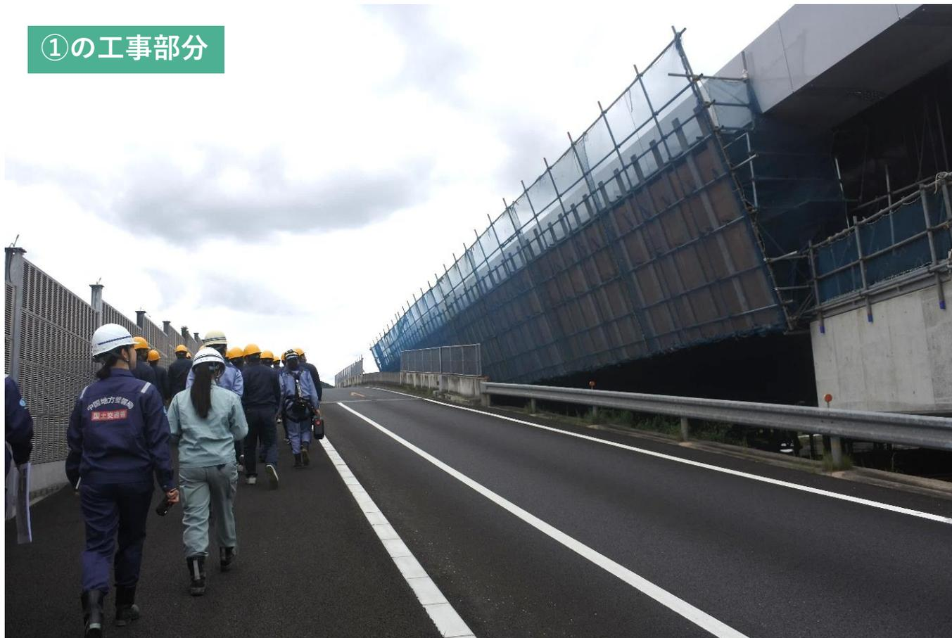
この写真の橋桁の下が、先ほど下から見上げた部分になります。ベントがあった部分ですね。既に橋桁や合成床版（鋼板のみ）が設置されています。
